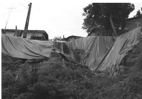
Foto 2 – Impermeabilização do solo com lonas plásticas. Fonte: Prefeitura de Camaragibe (2003).
