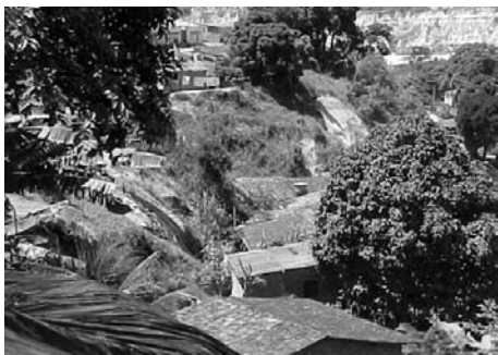
Foto 1 – Impermeabilização com lonas plásticas, Fonte: Prefeitura de Camaragibe (2003).
