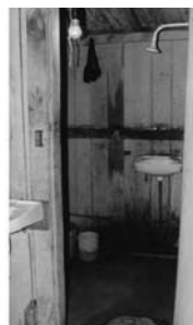
Figura 9 - Melhorias nas edificações da Vila da Barca promovidas por financiamento do programa Morando Melhor. Fonte: Fotos de José Júlio Lima (2002).
